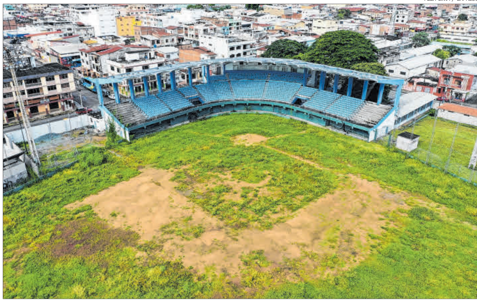
Actualidad. Así luce la cancha del Yeyo Úraga, ubicado en las calles Tungurahua y Cuenca, con maleza y grandes espacios de tierra descubiertos; los graderíos están intactos.
